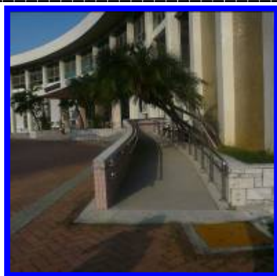
圖1 文英館入口坡道圖
